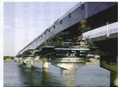
【湘南大橋工事進む！】平塚側より
